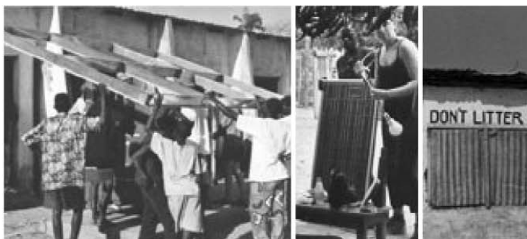
An der Partnerschule des Alexander-von-Humboldt-Gymnasiums in Gambia (Afrika) wurde eine Solarstromanlage installiert. Hinweise an der Schulmauer deuten auf umweltbewusstes Handeln.
