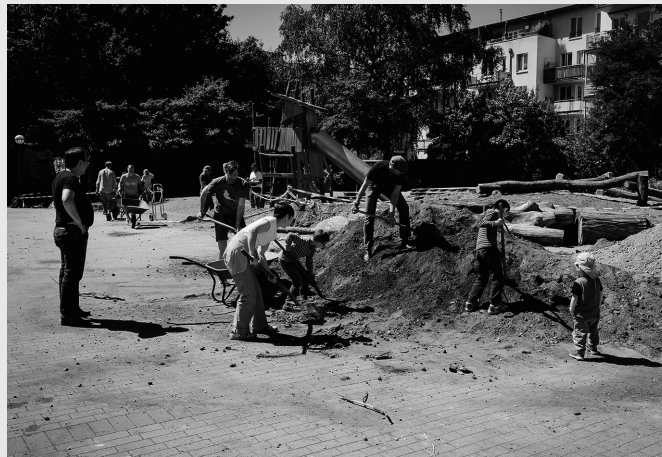
Abb.: Ein Großteil des Materials wurde mit Schubkarren bewegt. Foto: Stefan Behr
