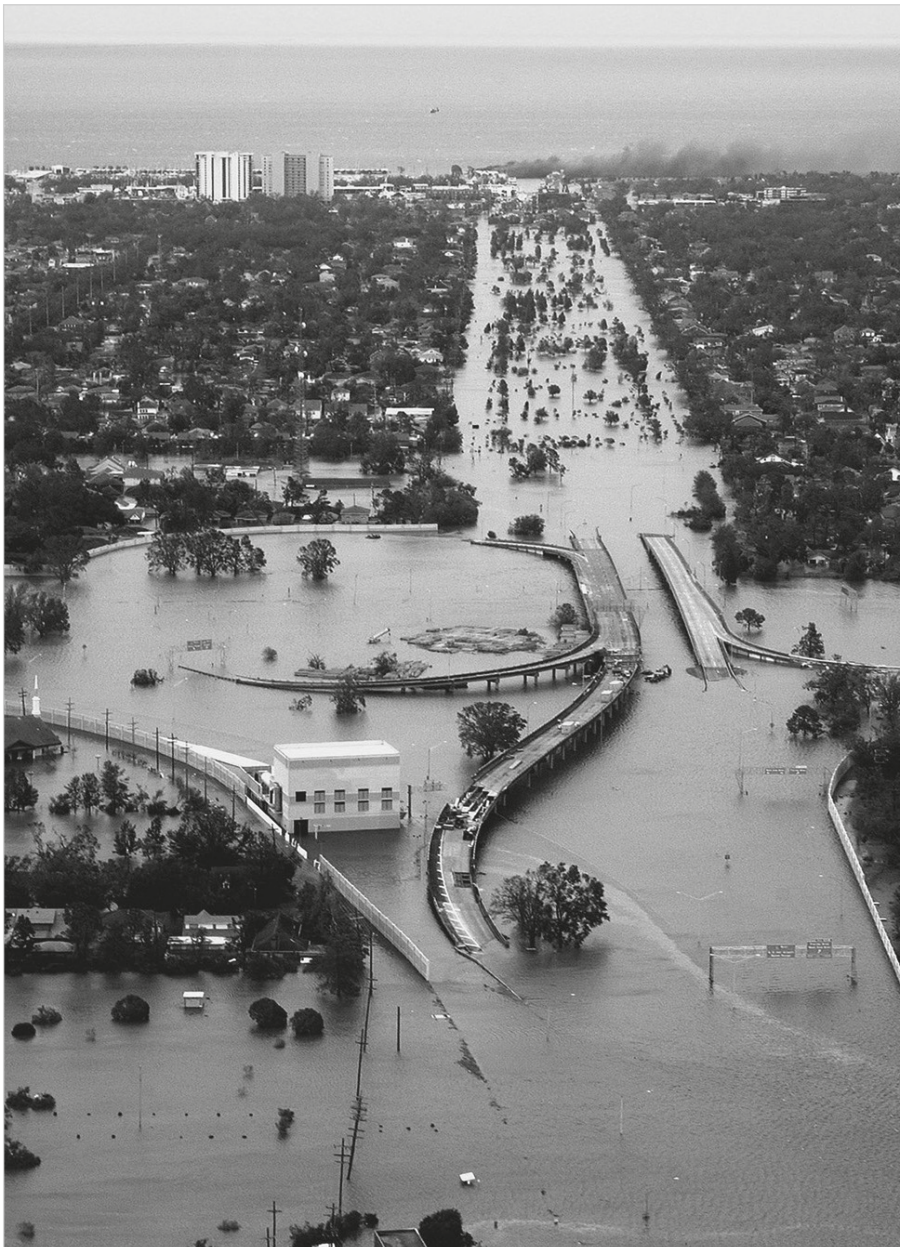
Abb. 3: New Orleans unter Wasser, am 29.8.2005 nach Hurrikan Katrina. 8 Foto: Wikimedia Commons, gemeinfrei
