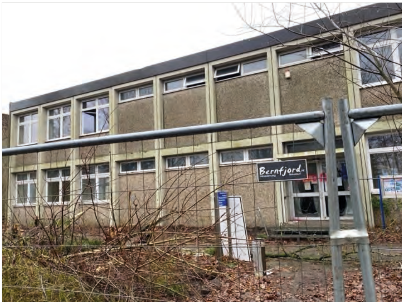
Abb.: Abriss des ZSU-Gebäudes 2023. Foto: Detlef Maisel
