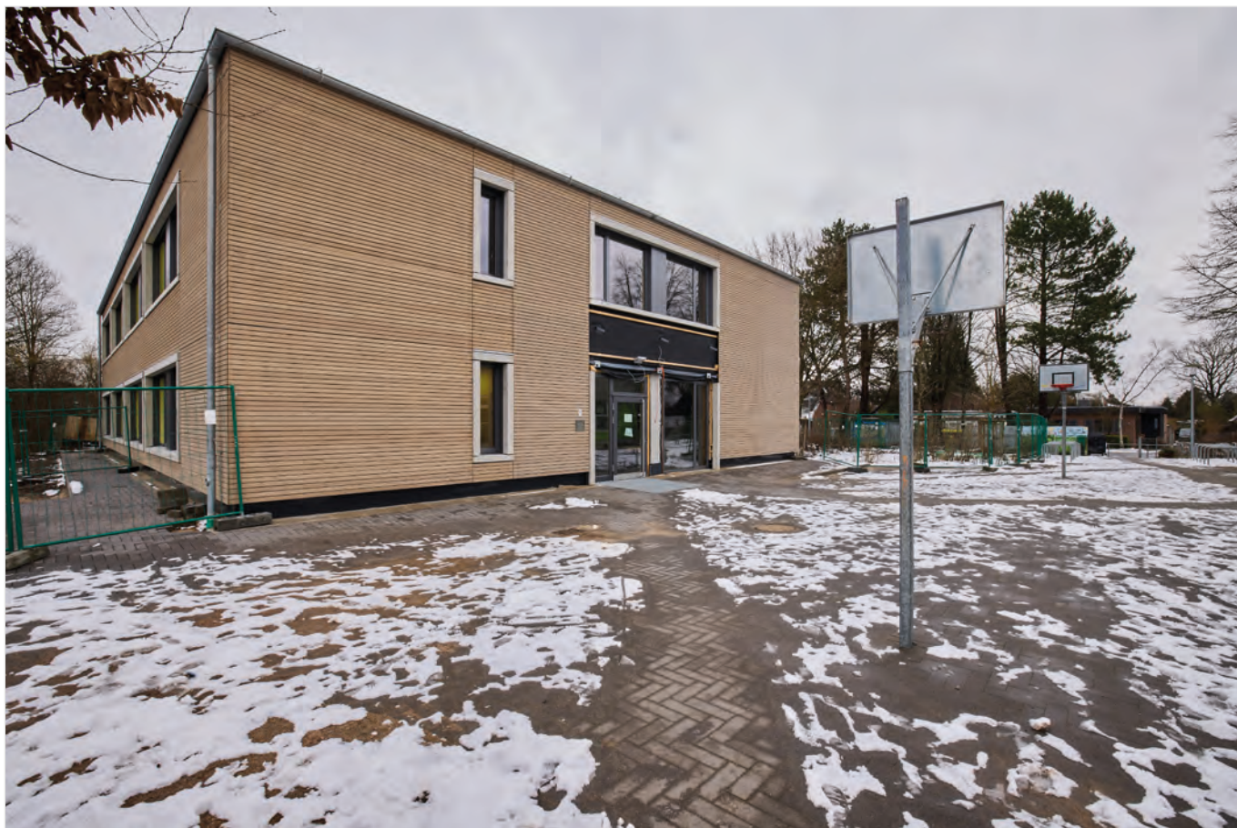
Abb.: Hamburger Klassenhaus Scheeßeler Kehre Typ 2B, Fertigstellung 2020. Foto: SBH | Schulbau Hamburg / 1998 Hewlett-Packard Company
